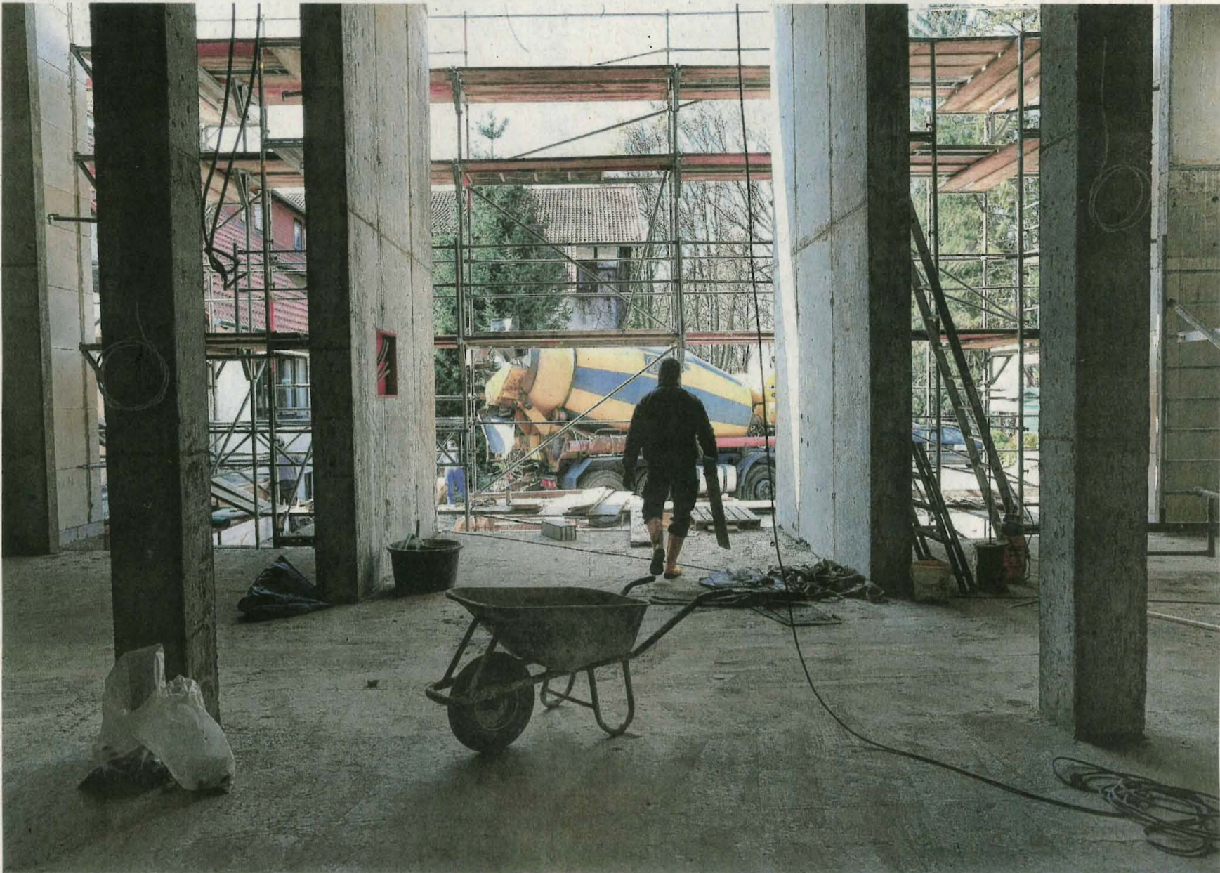
Hohe Decken, Glasfront: Ein repräsentativer Eingangsbereich soll nach Westen Richtung Parkplatz hin entstehen – dort wo auch schon zuvor der Haupteingang war. Ein Café samt Kaminecke schließt sich an. FOTO: TYLER LARKIN
